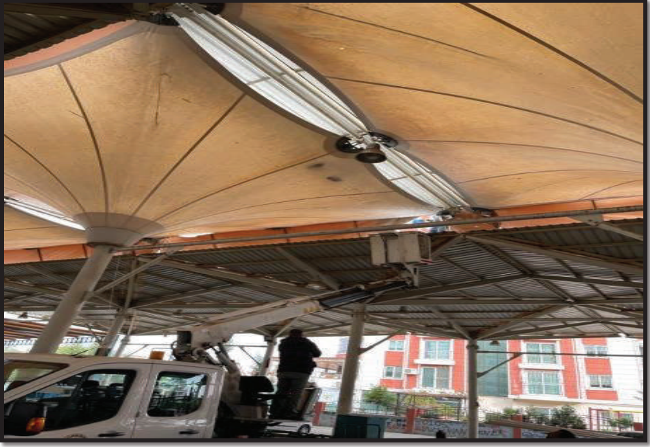
Ek Çatı Yapımı
