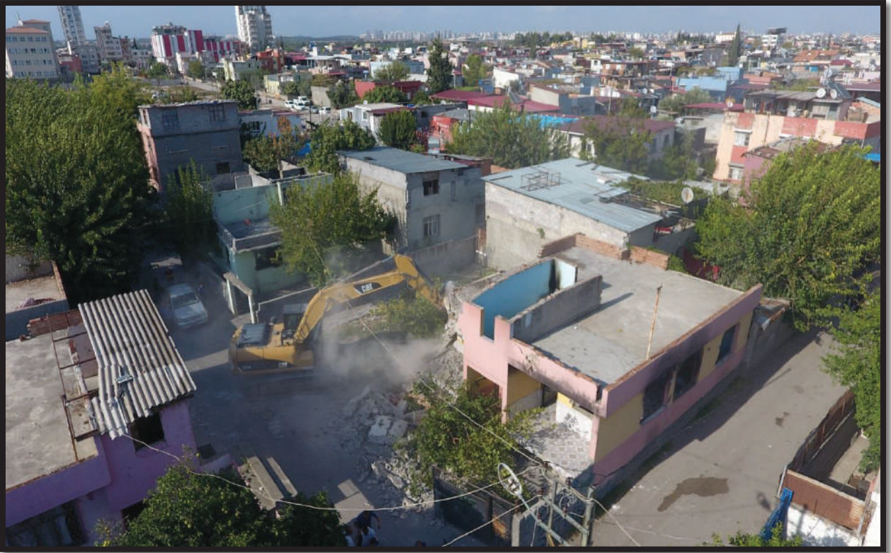
Ulubatlı Hasan Mahallesi Yıkım Çalışması
