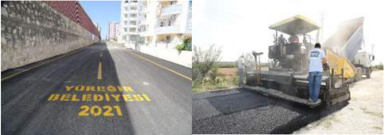
Resim: Asfalt Kaplama ve Yama Çalışmaları
