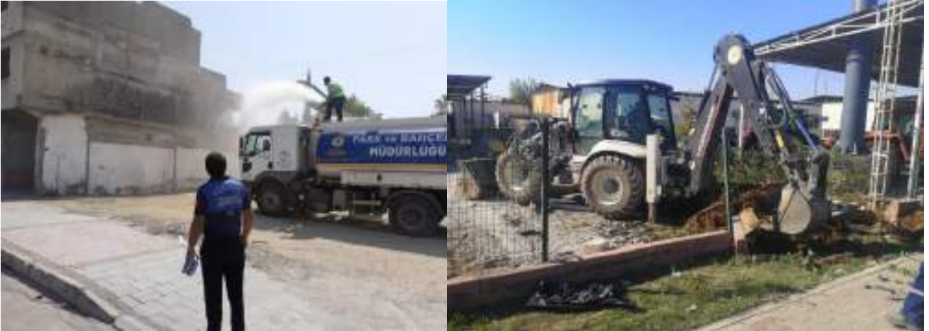
Resim: Çevre Güvenliği Sağlanarak Güvenli Bir Yıkım Yapılması
