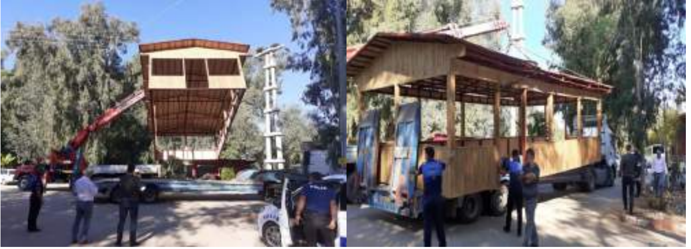
Resim: Barakanın Kaldırılması
