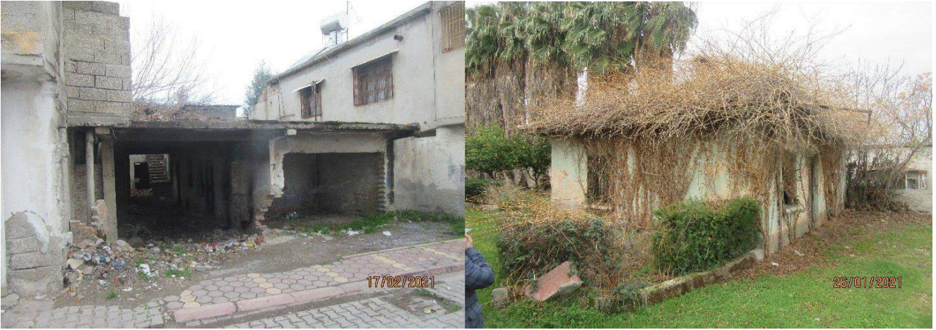
Resim: Metruk Bina Tespiti ve Yıkımı
