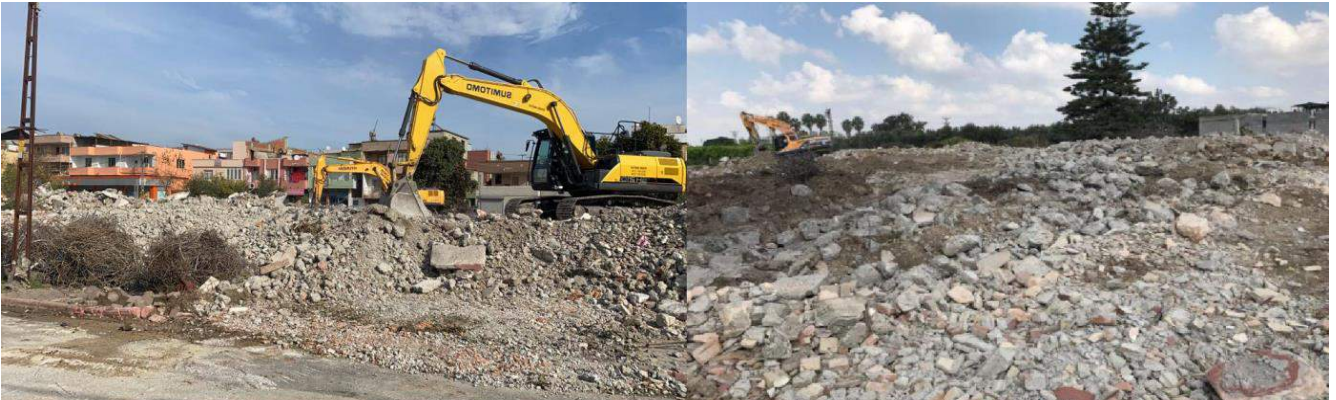
Resim: 6306 Sayılı Kanun Kapsamında Yıktırılan ve Parsel Güvenliği Sağlanan Riskli Yapı
