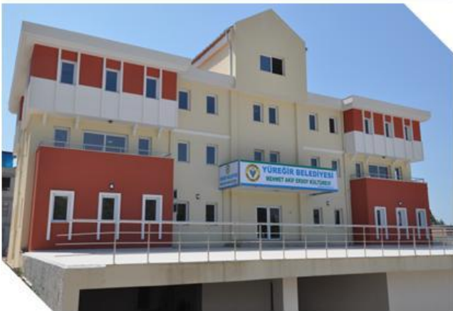
KÖPRÜLÜ MAHALLESİ MEHMET AKİF ERSOY KÜLTÜREVİ
